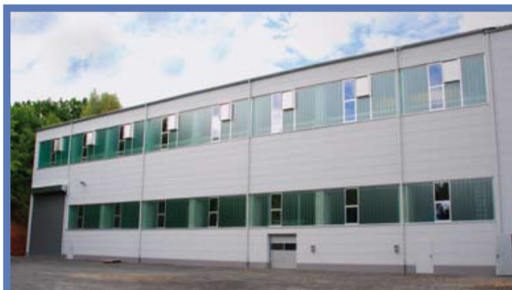
Die neue Halle wurde am 14. August eingeweiht.
