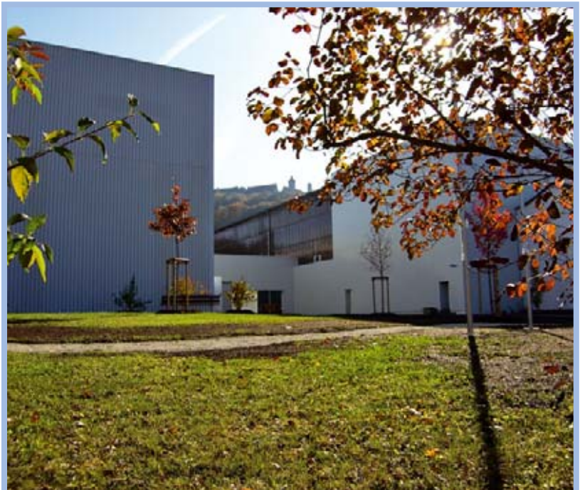
Die ersten Sanierungsmaßnahmen sind bereits erfolgt: So auch die umfangreiche Fassadensanierung des Firmengebäudes.
