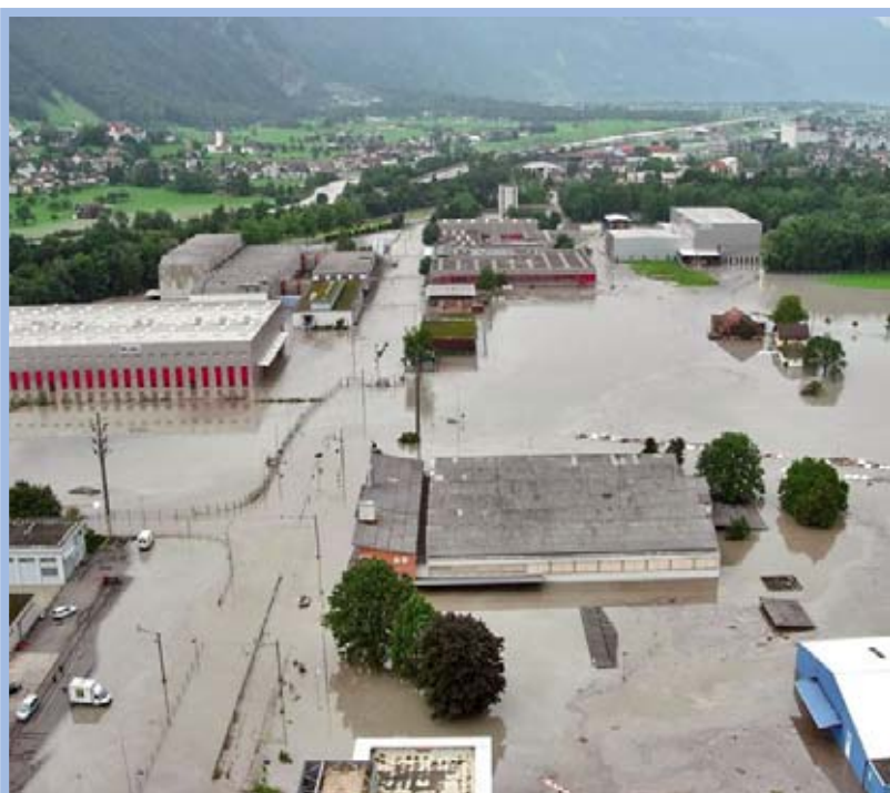
Das RUAG-Werk in Altdorf nach schweren Regenfällen 2005.
